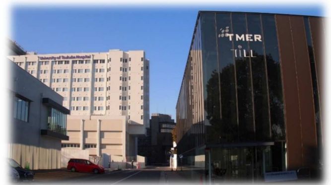
つくば臨床検査教育・研究センター一棟
